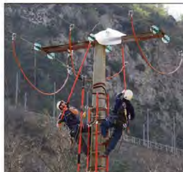
Des protections pour les oiseaux ont été posées sur les lignes électriques de la commune. (Photo F.P.)
